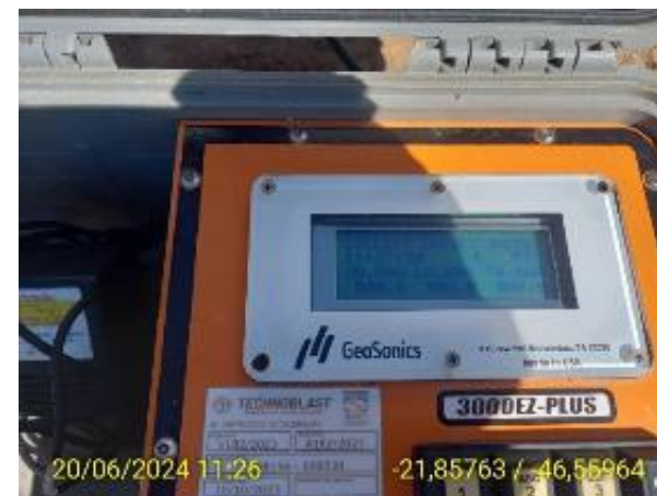
Foto 41 Registro do Equipamento GeoSonics 3000 – VB-04
