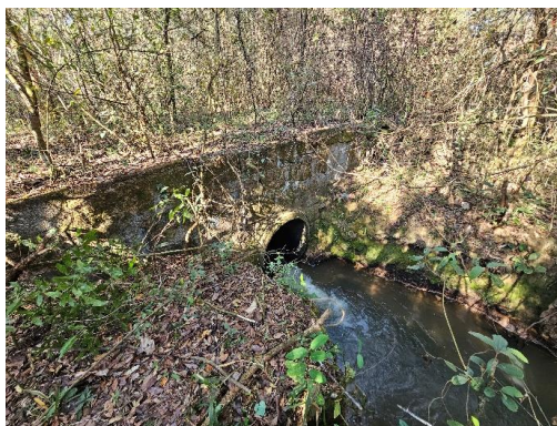
Foto 69 C-PC-098 Ponto controle com manilha embaixo de ponte antiga apresentando uma drenagem ativa, vegetação antropizada e sem registros de afloramentos rochosos.
