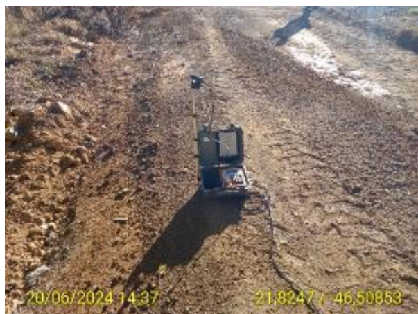
Foto 42 Registro da Instalação do Equipamento – VB-10
