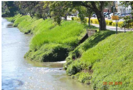
Registro do ponto de descarga de águas pluviais
